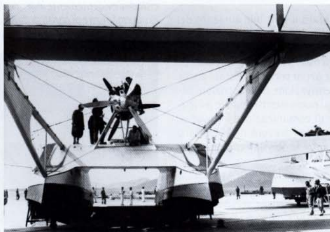
Vista posteriore di un S.55 che permette di apprezzare lungo le travi di coda il sistema dei cavi di comando delle superfici mobili.
