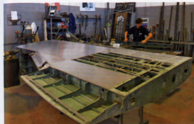
Sopra a sinistra: lavoro di ripannellatura con fogli di alluminio del ventre dell'ala destra esistente.
