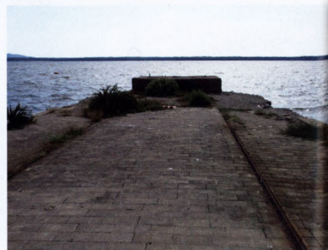
Il pontile con la base della gru di alaggio su cui arrivavano le rotaie per i carrelli portavelivoli
